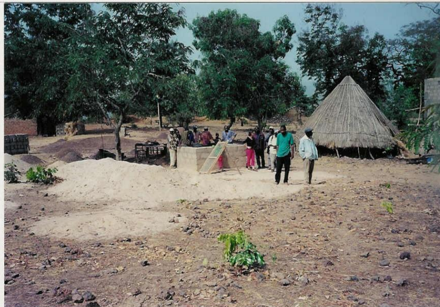
Ecole de MAYADINE (Préfecture de Mali) Tamisage du sable et réserve d'eau
