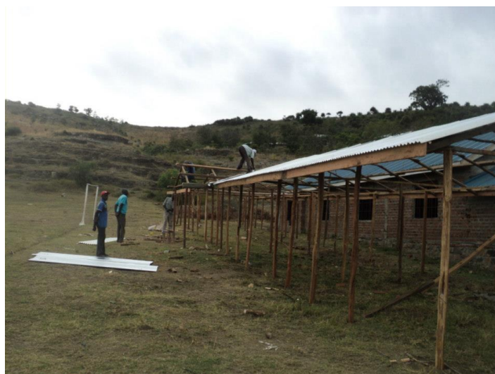
Építés közbeni képek
